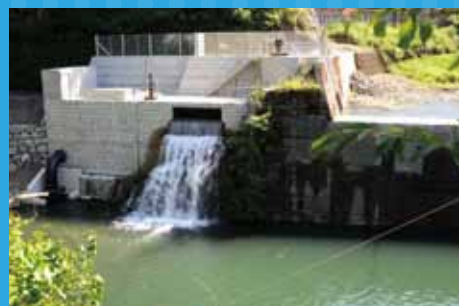
梶原町小水力施設
