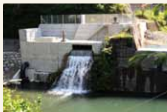
梶原町小水力施設
